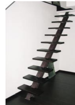
Stahlstiege unbehandelt geölt mit gebeizten Holzstufen
