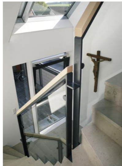
Treppengeländer aus Stahl, pulverbeschichtet mit Glasfüllung und Holzhandlauf
