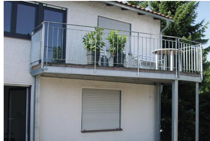
Balkon mit Geländer aus verzinktem Stahl
