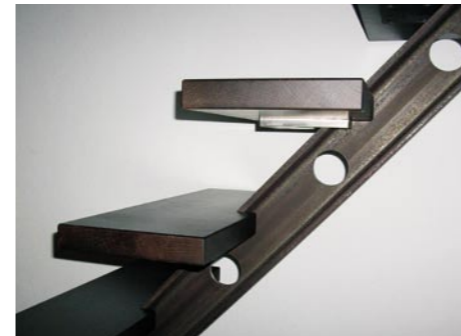
Stahlstiege unbehandelt geölt mit gebeizten Holzstufen
